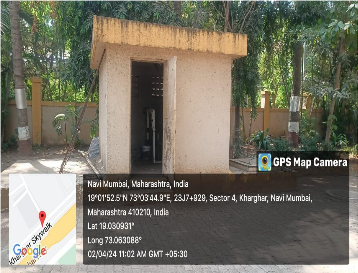
ETF (Effluent treatment)plant
